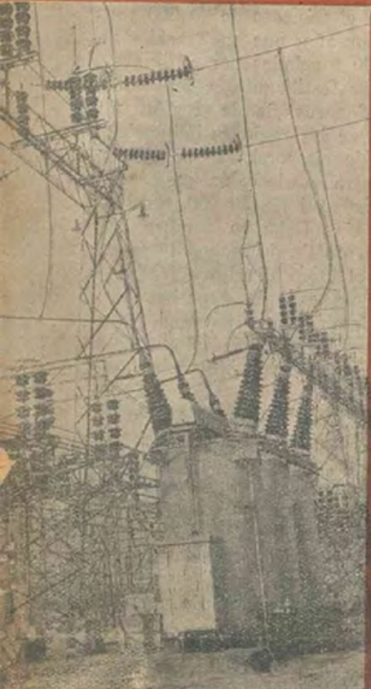
Vista parcial del desarrollo de la formidable represa. Un detalle de la Usina hidroeléctrica del Dnieprostroy: interruptores de aceite.
