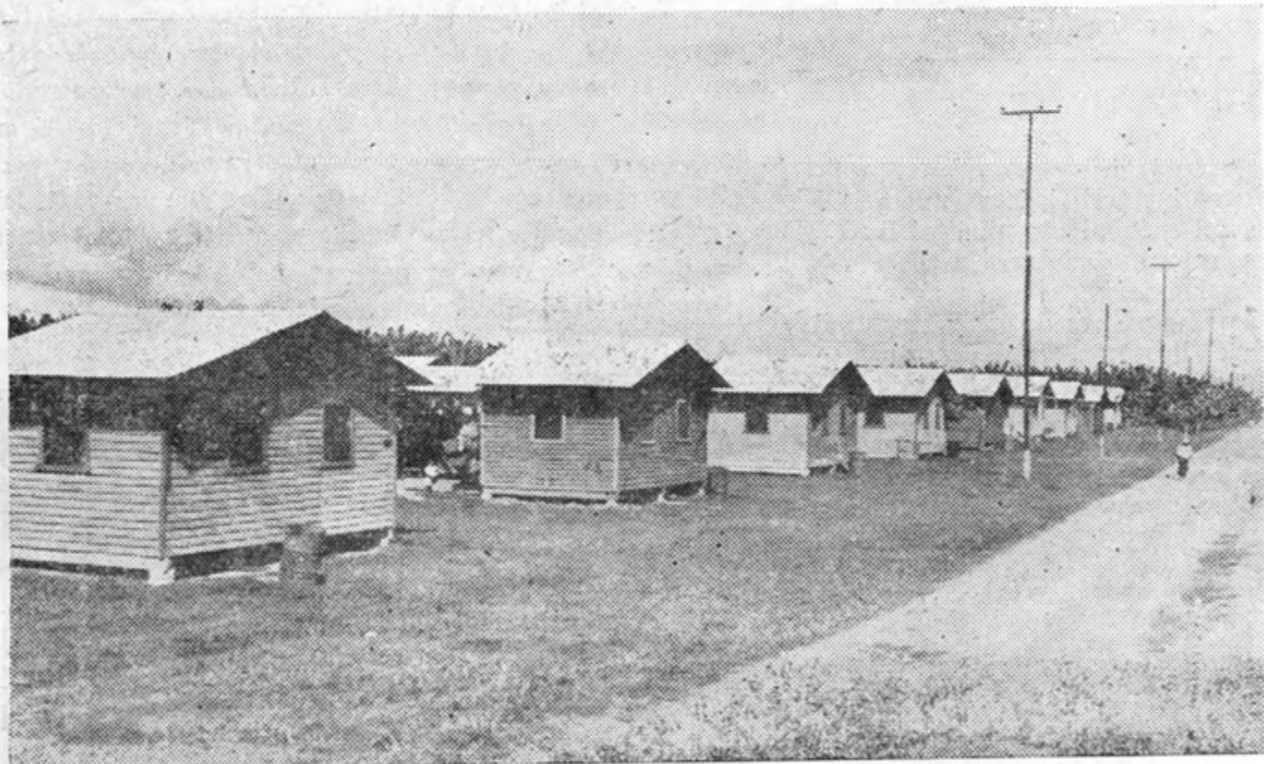
En las fincas bananeras de la Chiriquí Land Company, se están construyendo casas individuales para las familias de los trabajadores. Estas nuevas residencias obreras tienen instalación de luz eléctrica y agua potable en cañerías. Hay hasta la fecha más de 200 casas de este tipo en la zona bananera.
