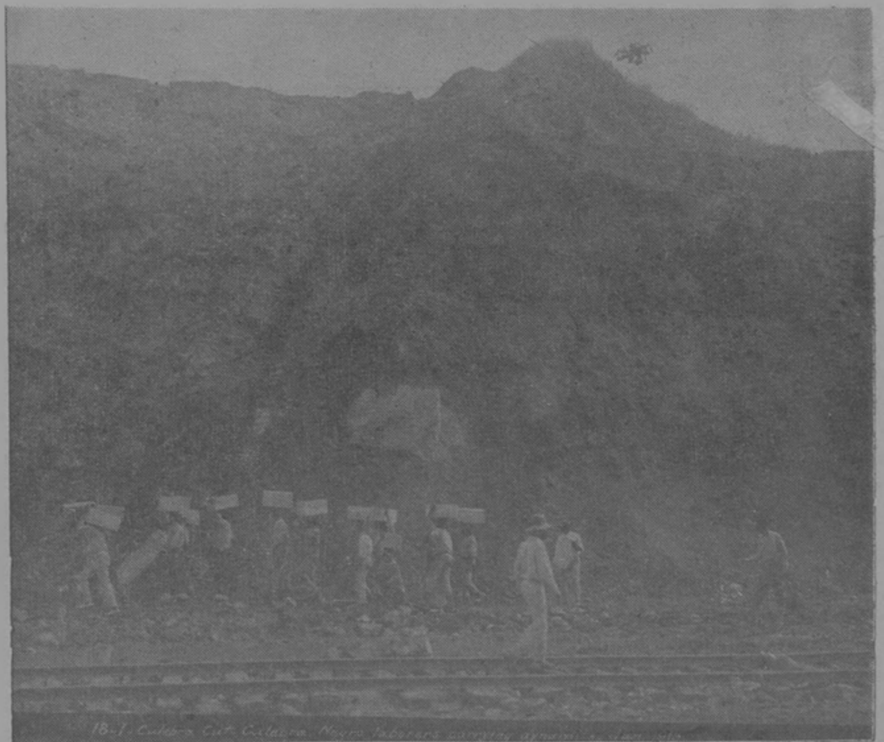
18-1. Carga de dinamita en los días de construcción.
