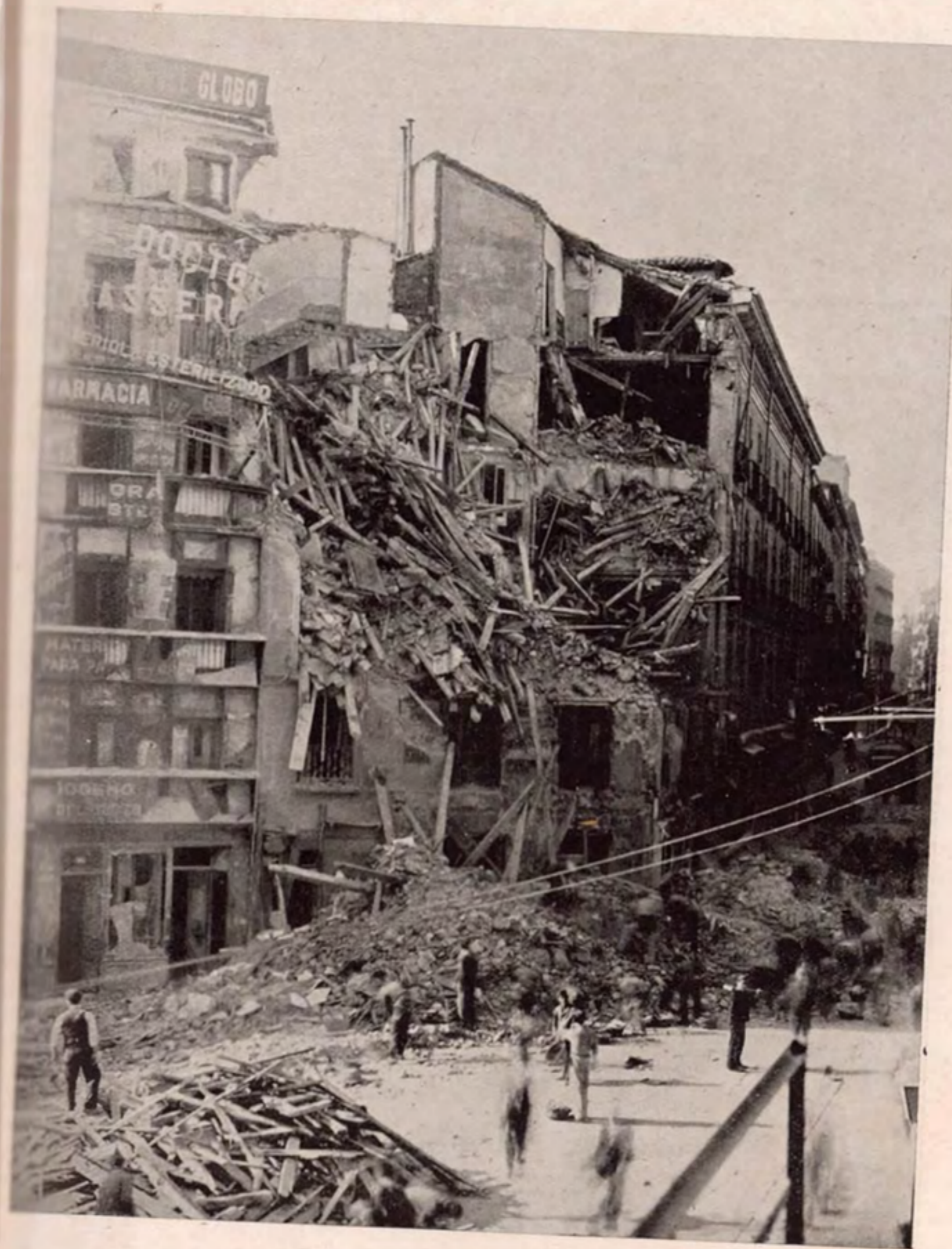
Edificio de la Plaza de Antón Martín, bombardeada por los aviadores fascistas.
