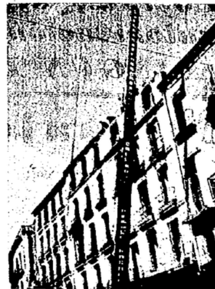
Los bomberos madrileños trabajan en el derribo de esta casa en la que sólo queda la fachada.
