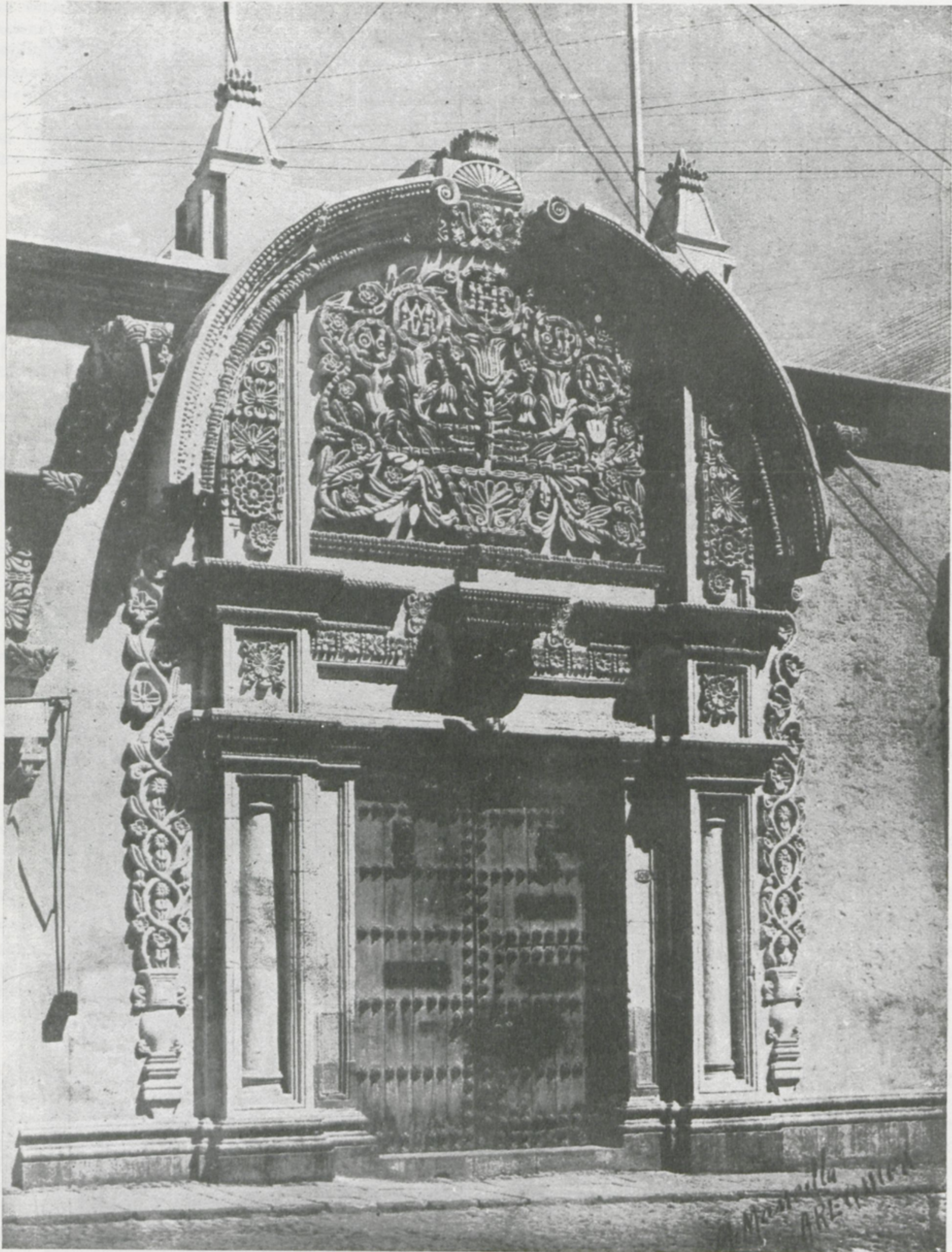
FACHADA DE UNA CASA PARTICULAR DE AREQUIPA Piedra volcánica blanca gris. La técnica indígena, robusta e ingénua, de la ornamentación, logra la fusión natural con la estructura española. Se realiza el mestizaje.
