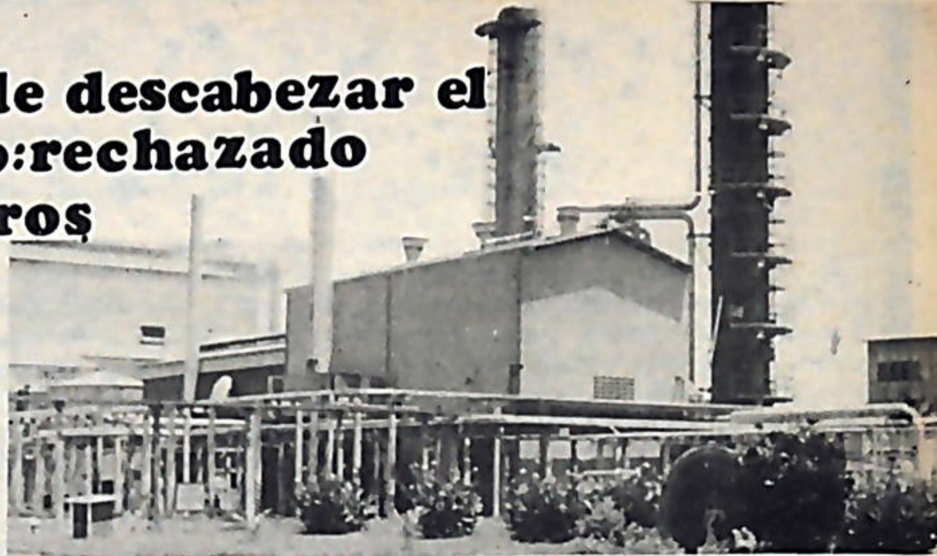
Planta de Fertica.
